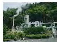
地熱発電は、地下から取り出した蒸気を使ってタービンを回して電気を作ります。地熱発電は地面の下の蒸気を使うので、火力発電や原子力発電とは違って、石油やウランといった燃料を外国から輸入する必要がありません。二酸化炭素や放射性廃棄物といった地球に有害とされる物を出さないのも大きな特徴です。
